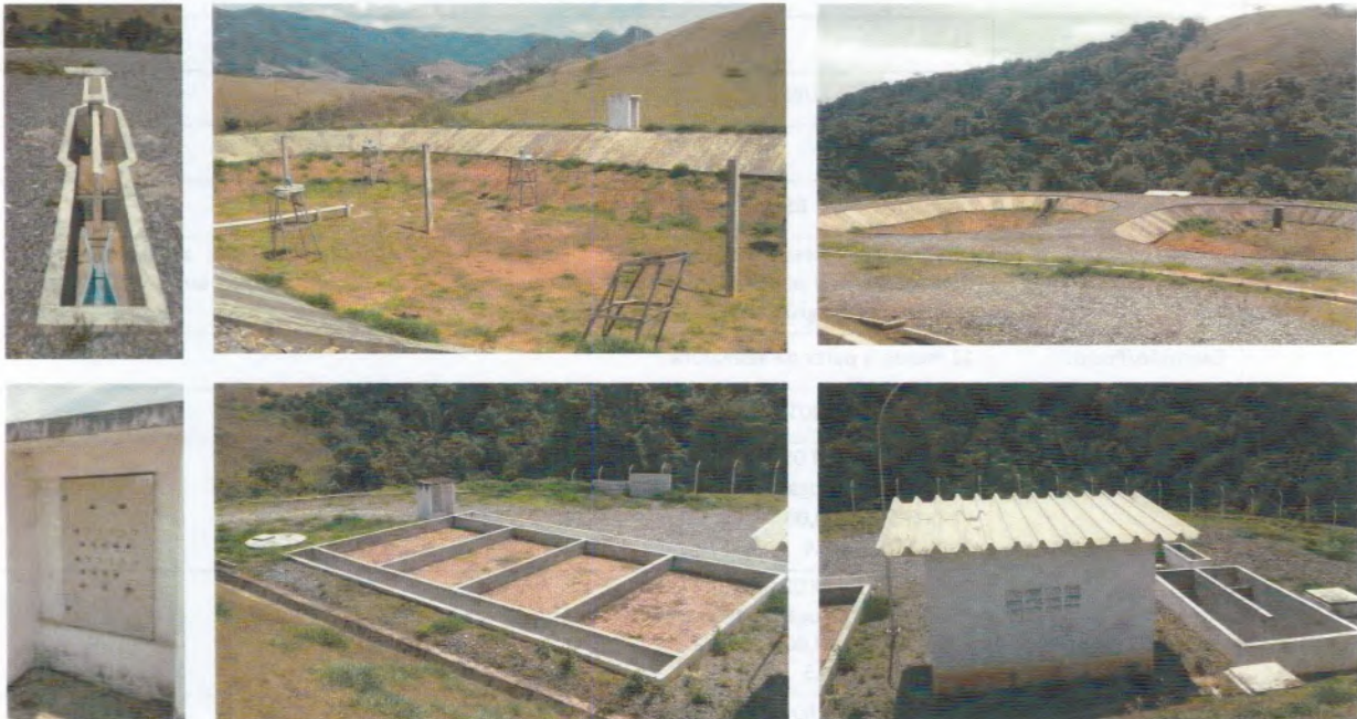
ESTAÇÃO DE TRATAMENTO DE ESGOTO DE SÃO JOSÉ DO BARREIRO
